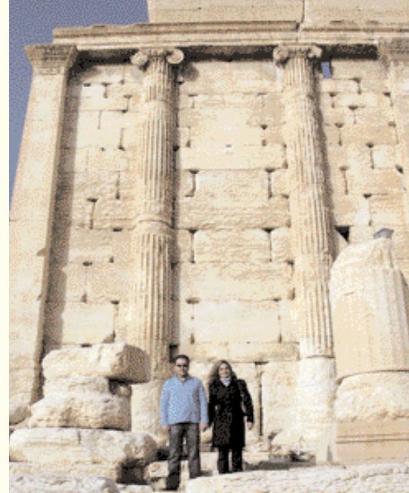
Muro del templo de Baal, de cerca de 18 metros de altura جدار لمعبد بعل يصل ارتفاعه إلى حوالي 18م
